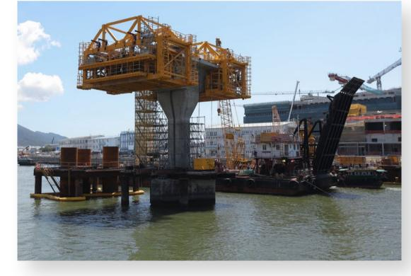
筋及 330 立方米混凝土 (相等於減少 747 噸碳排放),通過使用低碳碳混凝土,更減少1,253噸碳排放。
